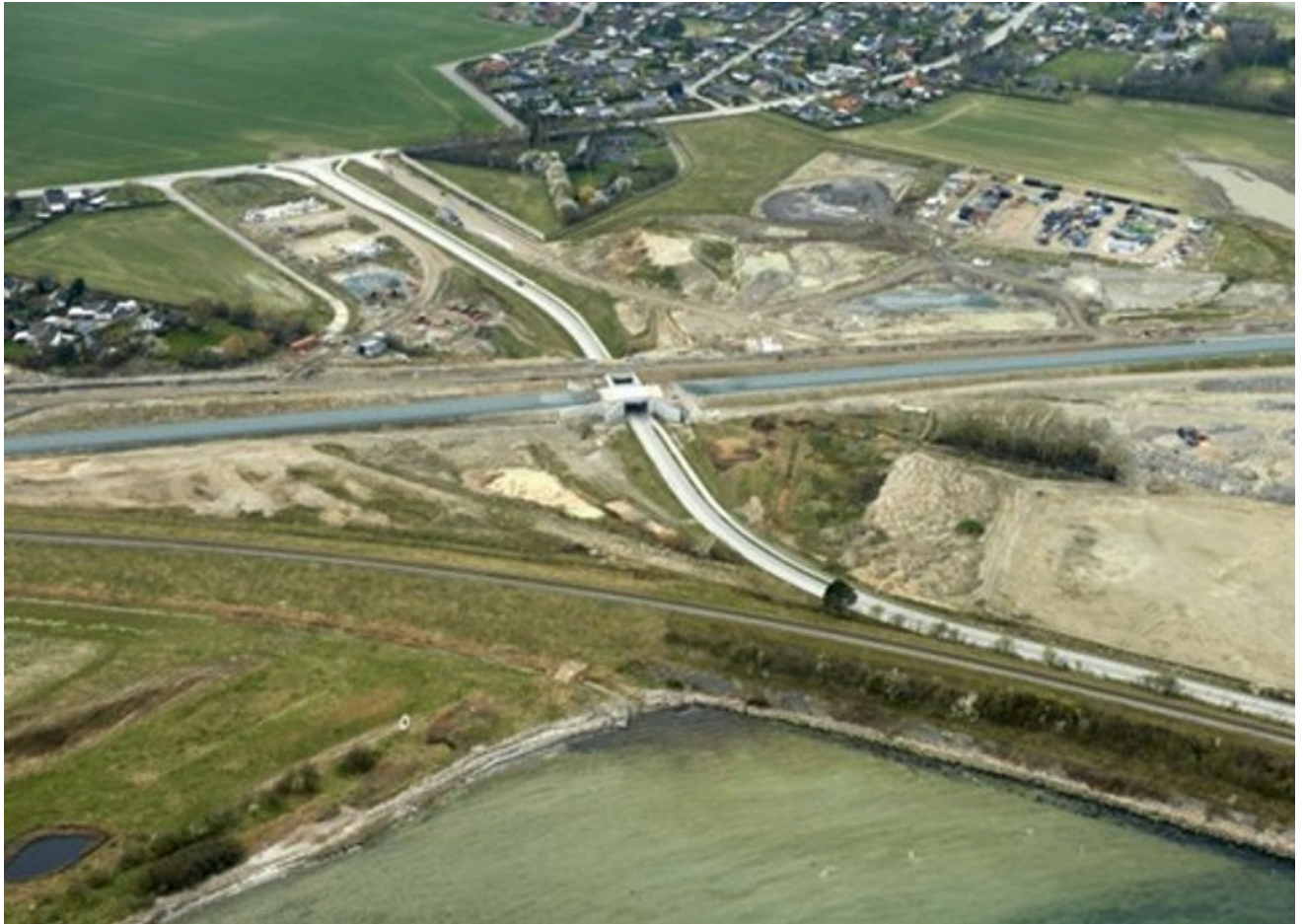
Figur 7 - Landanlæg på Falster med eksisterende vej og kommende jernbane til den Nye Storstrømsbro (Foto: Vejdirektoratet, 2023).
